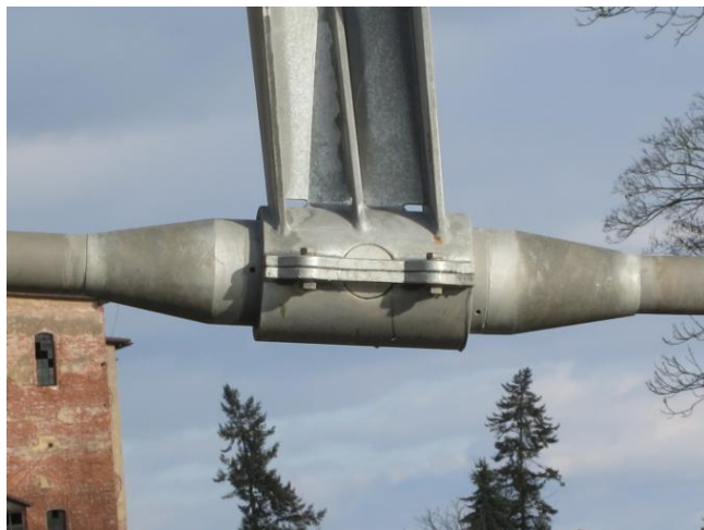
Obr. 2 Kloubově uložená spojka táhel ve zlomu křivky
