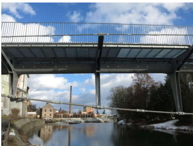
Obr. 1 Třícípé příčnickové prvky s táhly
