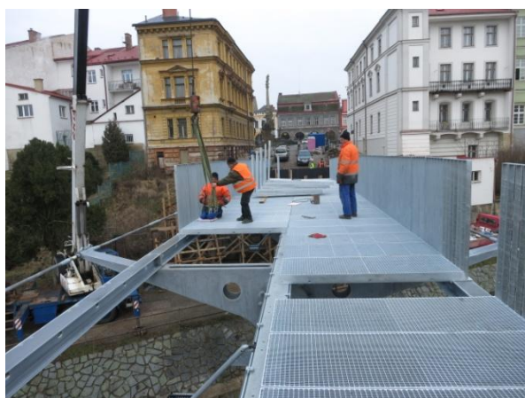
Obr. 4 Montáž mostovky z pororošťů
