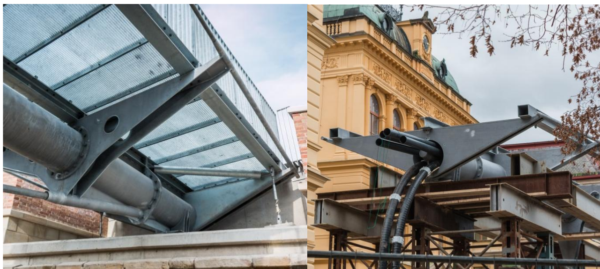
Obr. 6 Patní svařenec a stabilizační táhlo Obr.7 Instalace vodovodu a chrániček VN
