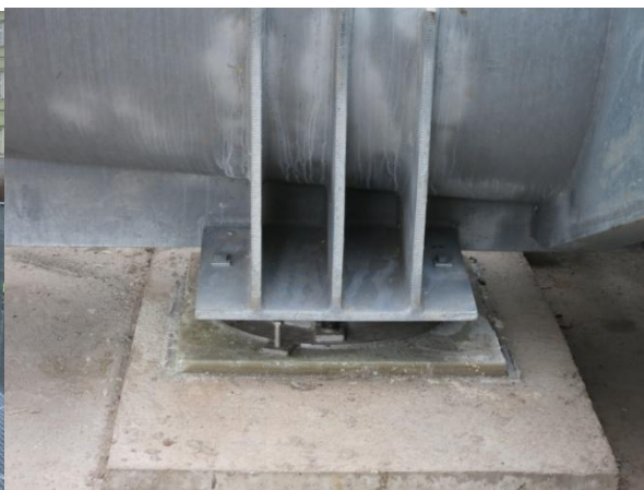
Obr.5 Uložení mostu na ložisko
