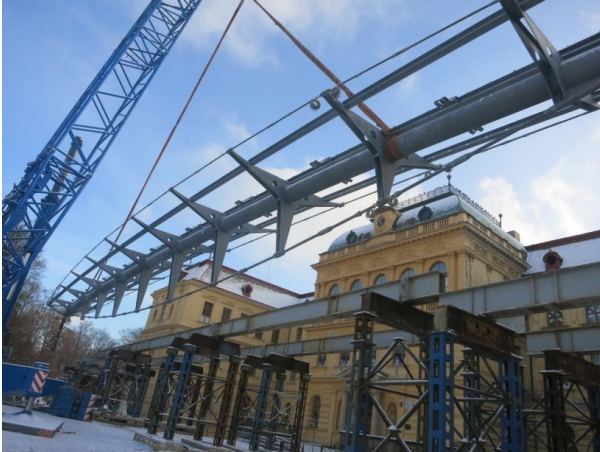
Obr. 8 Zdvih lávky z provizorních podpor při montáži
