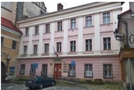
Obrázek č. 1: Budova MěÚ - OSVZ, OSPOD, nám. Československé armády č.p.3
